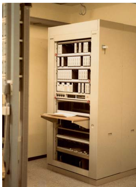
Bild 5: Relaisvorrichtung eines Allfernsprechers AF 300
