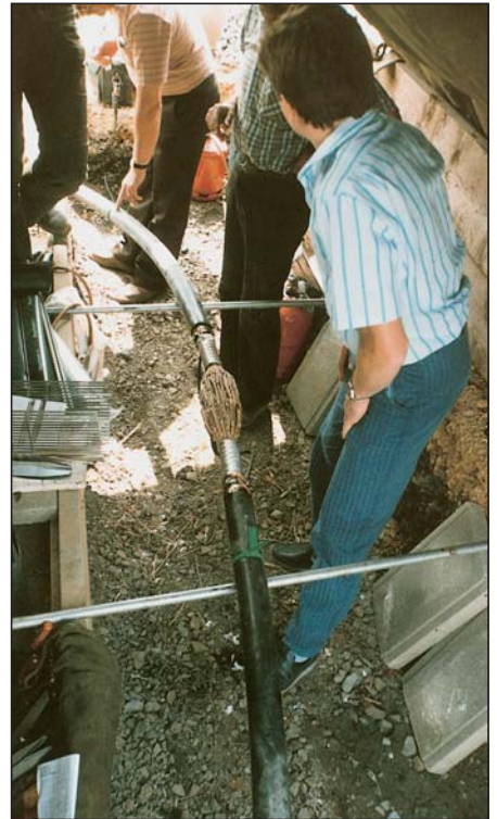
Bild 2: Montage einer Verbindungsmuffe an einem Streckenfernmeldekabel
