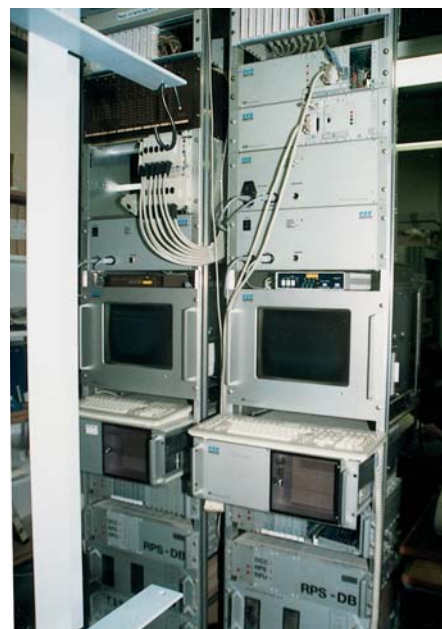
Bild 9: Zentrale Steuereinheit MAS90 und zugehörige Netzwerkeinrichtungen
