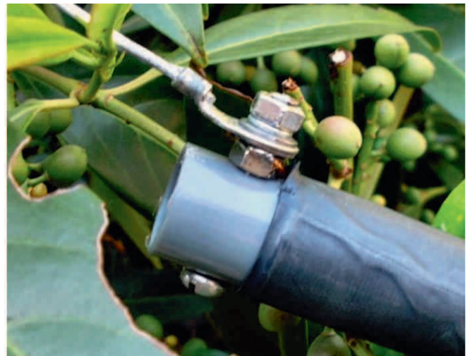
Vue bucolique de l'extrémité de la self
