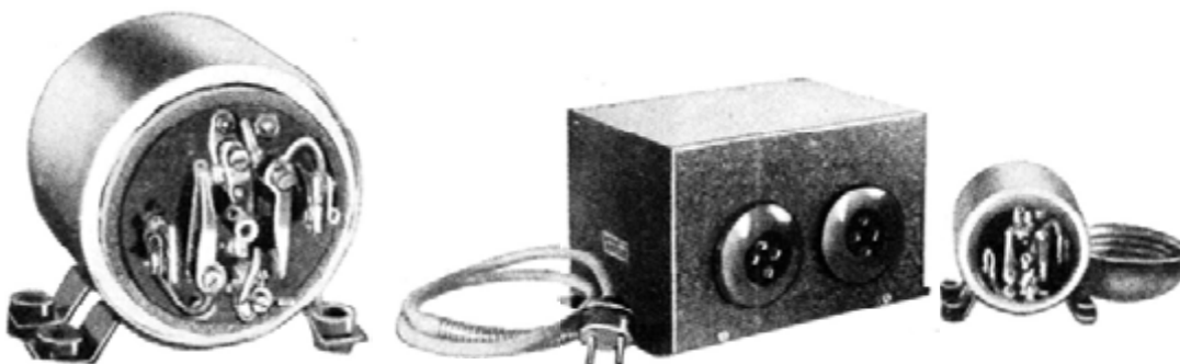
Das Unterbrechersystem des Telwa-Wechselrichters.
