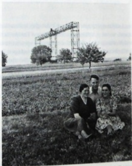
Die Funkleitstrahlanlage "Auf Dachstg" bei Maulburg
