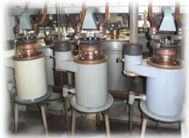
Röhren, 120 kW Sender
