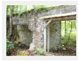
Das Gebäude 1 hat massive Splitterschutzvorbauten und einen breiten Durchlass. Es wurde aus Natrustein, Ziegeln und Beton gebaut.
