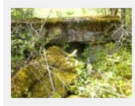
Der Bunker wurde aus Ziegeln und Beton gebaut. Die Deckenstärke beträgt ca. 40 cm und bot damit nur Splitterschutz.
