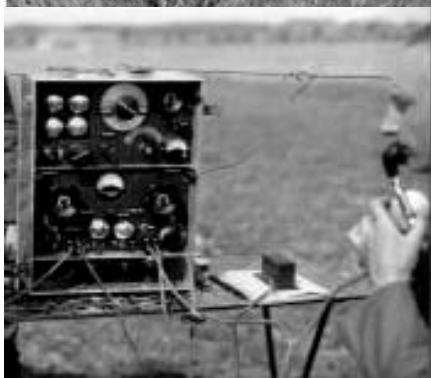
Ahemo 31. Die Fotos zeigen das Gerät bei der Vorführung vor ausländischen Besuchern im Beisein von Hauptmann Baltzer, 1931/32 Referent im Reichswehrministerium. Dieses Gerät könnte der Ahemo-Beitrag zur letzten und entscheidenden Entwicklungsstufe der Funksprechgeräte gewesen sein. Man sieht zwei Röhren im Sender und vier im Empfänger. Allerdings ragen bei
